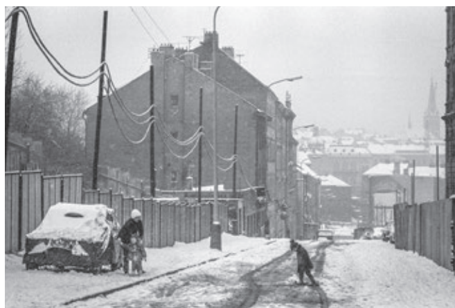
Jeseniova v období demolic
