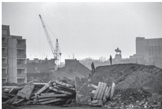
Skládka během asanace, zřejmě u Lupáčovy ulice
